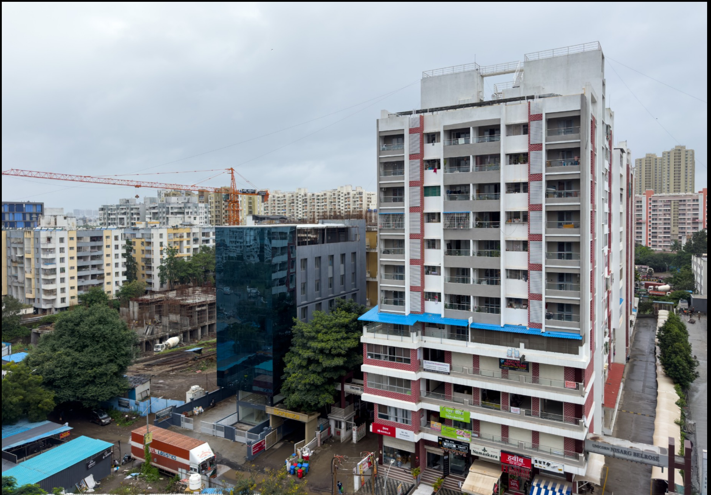
Weitere Baustelle auf der anderen Strassenseite
